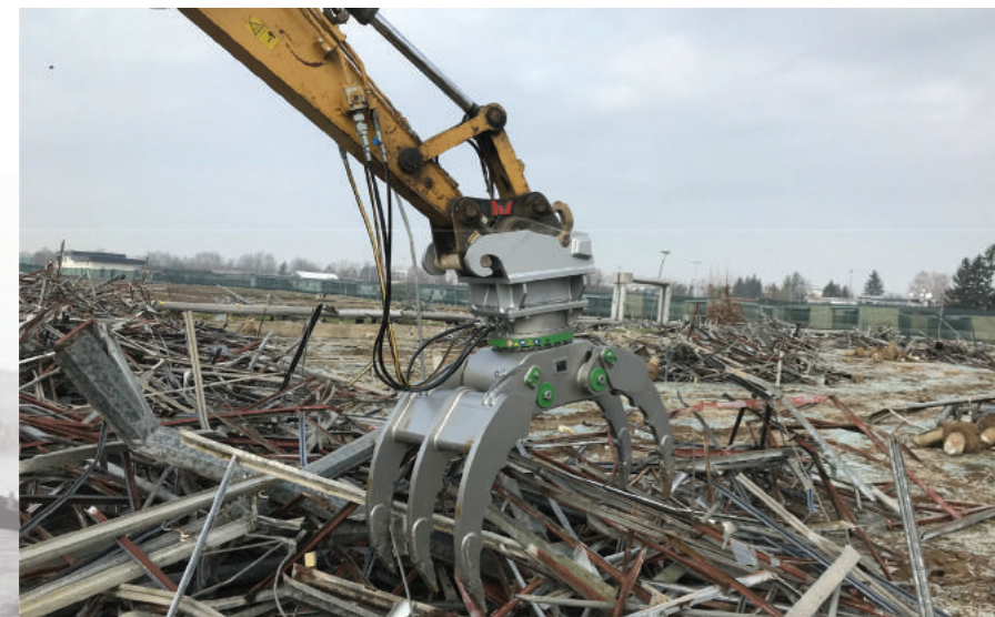
Alligator-Greifer - das beste Werkzeug für scharfen Stahlbau
